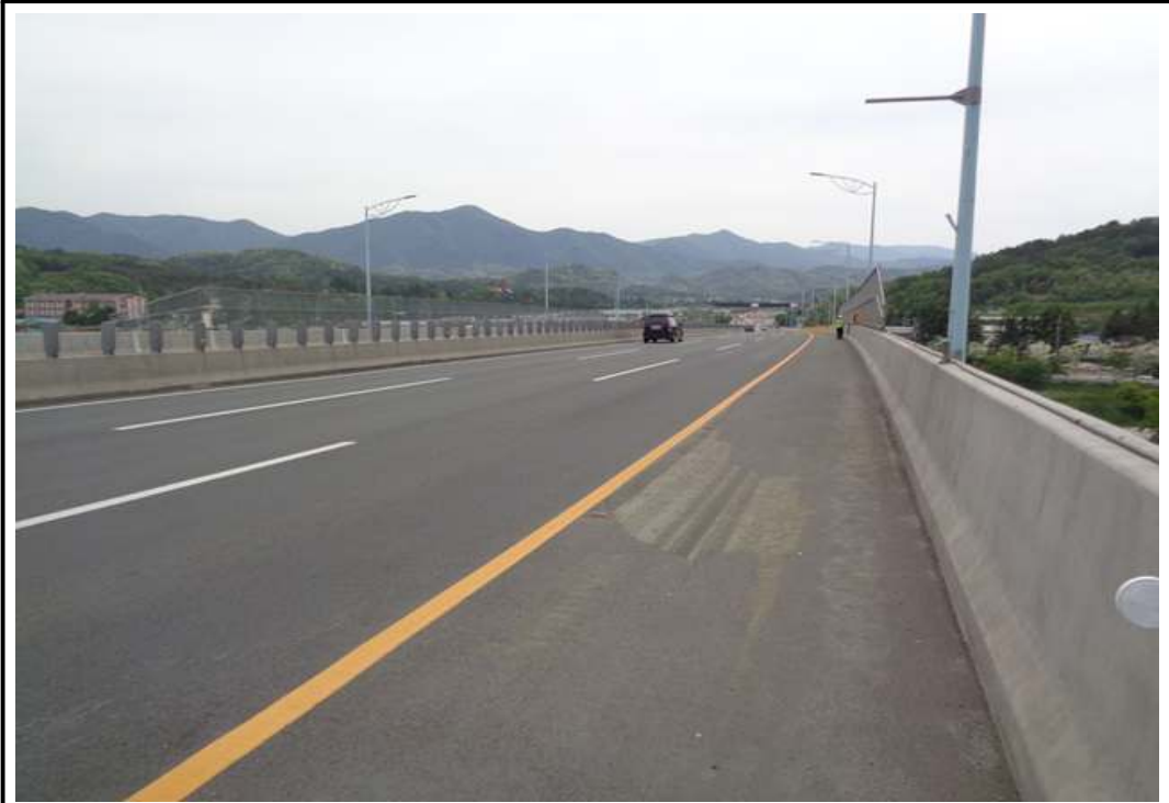
난간 및 방호벽 전경
